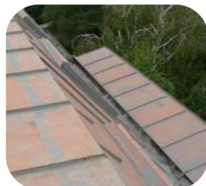
b. Sind nur kleinflächige Schäden (weniger als 25% der Gesamtfläche) festzustellen, die Tragfähigkeit für einen Folgeanstrich gegeben und die empfohlenen Schichtstärken nicht überschritten, so sind diese mit einer roststoppenden Grundierung auszuflecken und danach vollflächig mit der Deckbeschichtung zu überstreichen.
