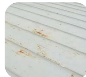
c. Betreffen die Schäden mehr als 25% der Gesamtfläche, ist die Tragfähigkeit für einen Folgeanstrich gegeben und werden die empfohlenen Schichtstärken nicht überschritten, wird empfohlen, vollflächig eine roststoppende Grundierung und im Anschluss eine vollflächige Deckbeschichtung aufzubringen.
